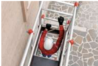
Accesso all'area di lavoro completamente protetta, grazie ai parapetti montati dal basso. Safe access to the work area is fully ensured by the guardrails assembled from below
